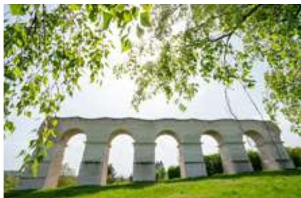
Ars-sur-Moselle, aqueduc romain
